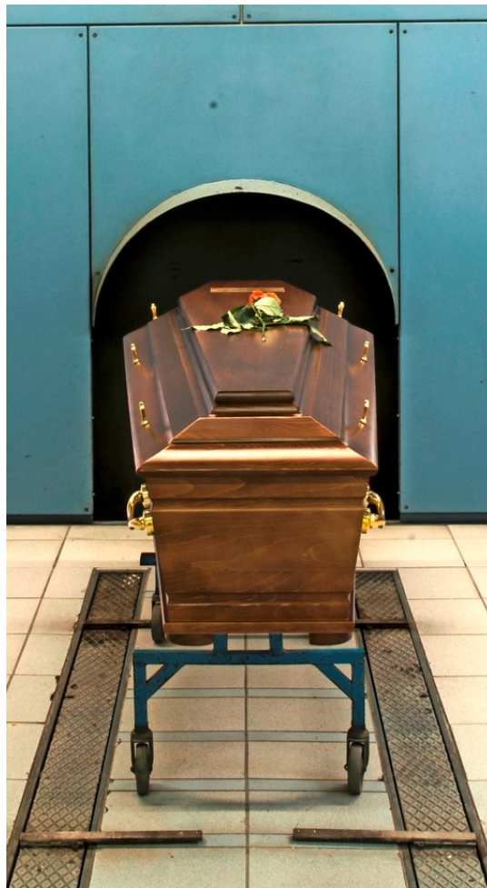
La Ville de Lausanne doit refaire les quatre fours du crématoire de Montoie. Ils sont en service depuis 1994. DR
